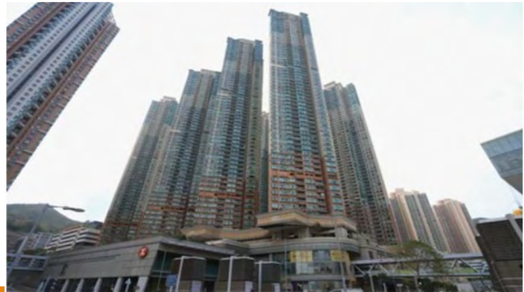
城中駅錄2房單位蝕讓沽出
